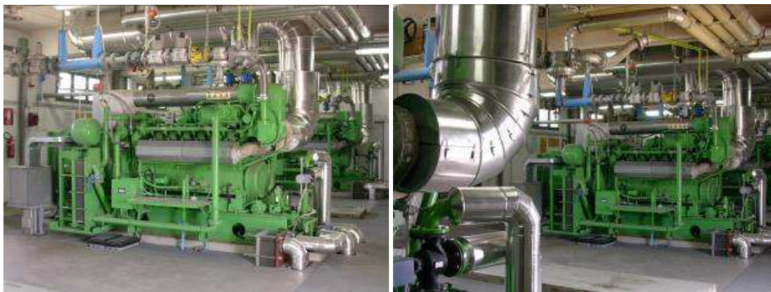
Figura 13-14: Immagini dei motori dell'impianto di Cogenerazione della Ecoserdiana Spa
