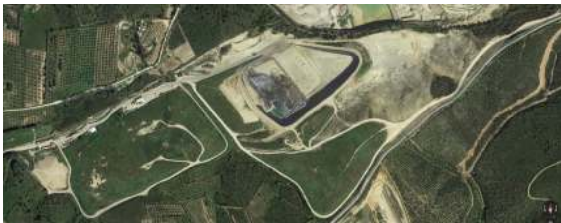
Figura 7: Vista aerea Impianto di Smaltimento della Ecoserdiana Spa
