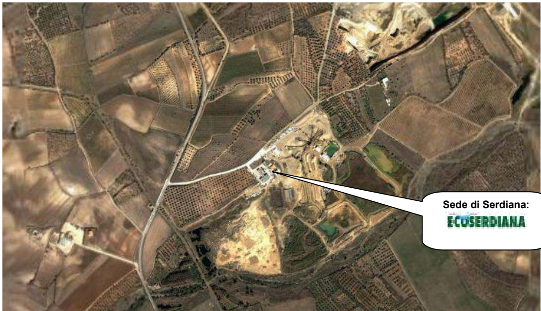
Figura 4: Vista aerea Impianto di Cogenerazione e Laboratorio della Ecoserdiana Spa
