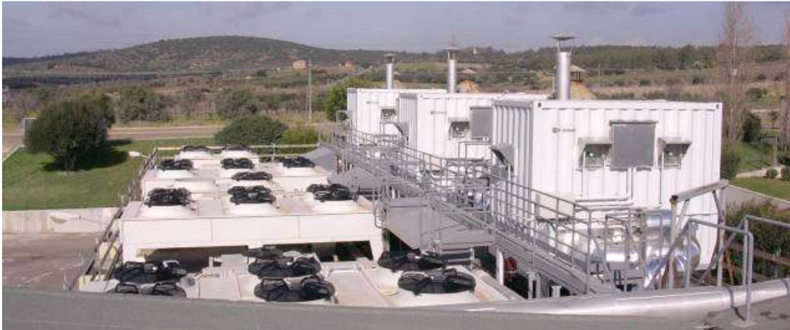
Figura 16: Vista dall'alto dell'edificio che ospita i motori dell'impianto di Cogenerazione della Ecoserdiana Spa
