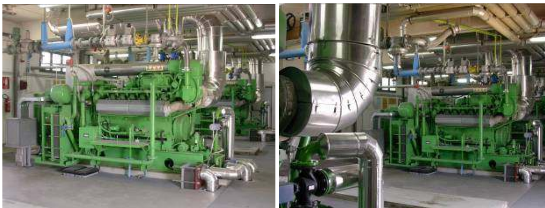
Figura 14-15: Immagini dei motori dell'impianto di Cogenerazione della Ecoserdiana Spa
