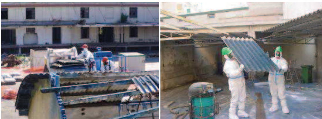
Figura 11-12: Immagini di operai del reparto bonifiche ambientali della Ecoserdiana Spa al lavoro
