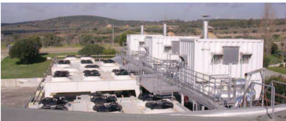
Figura 15: Vista dall'alto dell'edificio che ospita i motori dell'impianto di Cogenerazione della Ecoserdiana Spa
