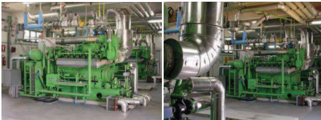
Figura 13-14: Immagini dei motori dell'impianto di Cogenerazione della Ecoserdiana Spa
